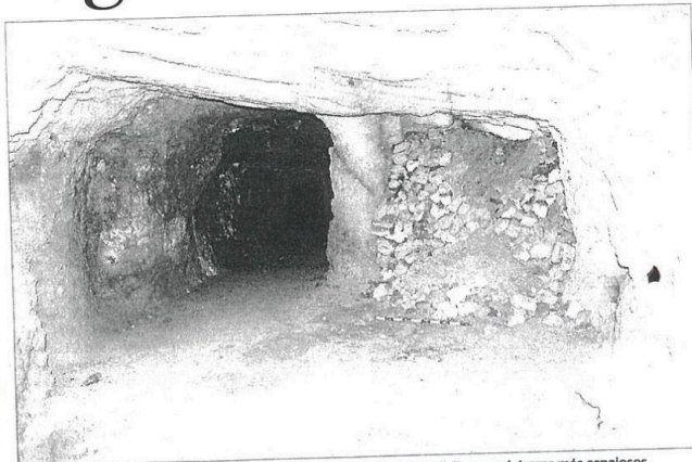
La galeria presenta uns 2-2,50 metres d'amplària i prop de 2 metres d'altura, amb trams més espalosos.
